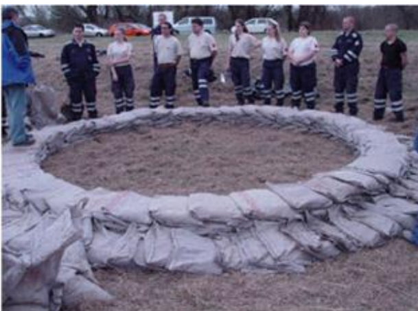
6. sz. képcsoportok: A buzgár ellennyomó medencéjének kiépítése
