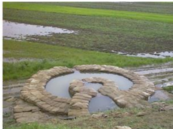
5. sz. képcsoportok: A buzgár kiépített ellennyomó medencéje
