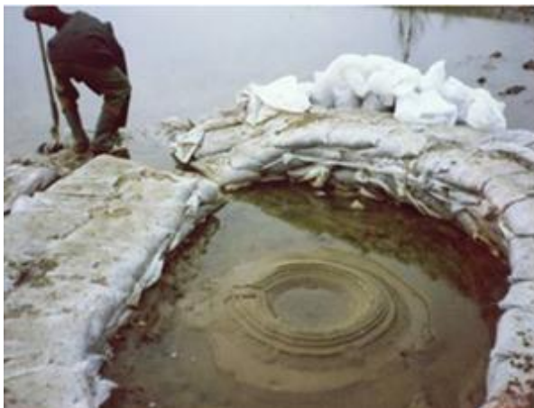
5. sz. képcsoportok: A buzgár kiépített ellennyomó medencéje
