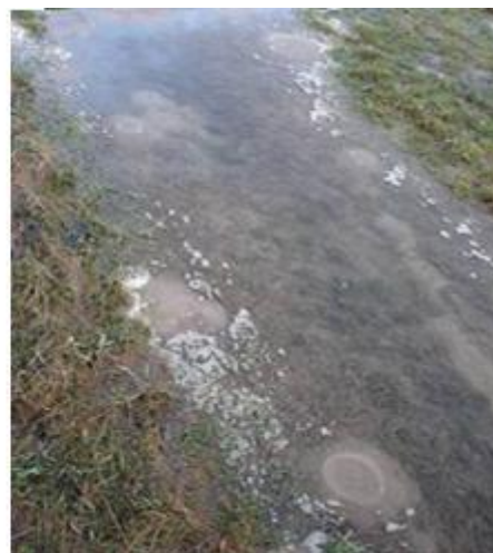
2. sz. kép: Buzgár csoport. Védekezés a jelenségek összevonásával, szorítógáttal.
