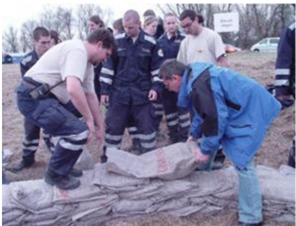
6. sz. képcsoportok: A buzgár ellennyomó medencéjének kiépítése
